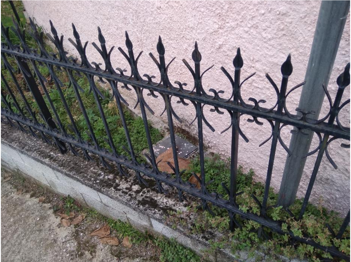
Εικόνα 2 Υδρόμετρο μέσα σε φρεάτιο με μεταλλικό καπάκι σε δυσπρόσιτο ιδιωτικό σημείο
