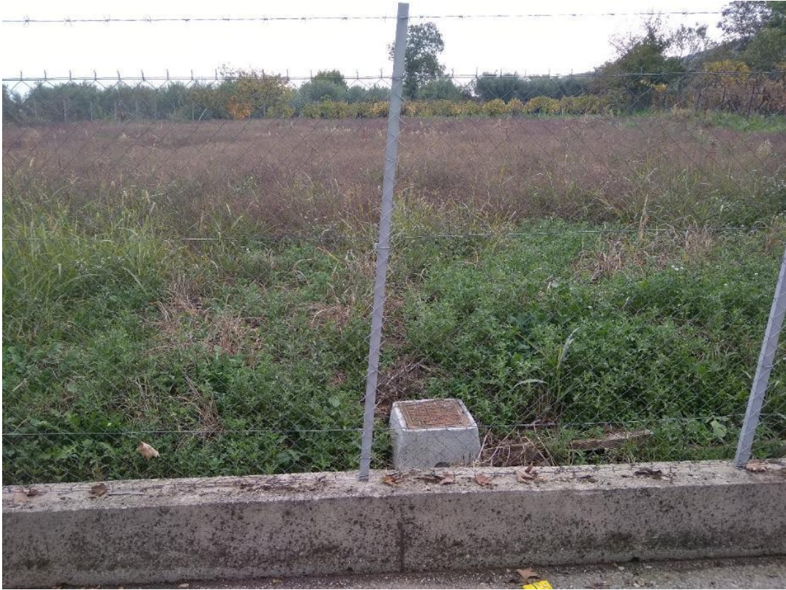
Εικόνα 1 Υδρόμετρο μέσα σε φρεάτιο με μεταλλικό καπάκι σε δυσπρόσιτο σημείο
