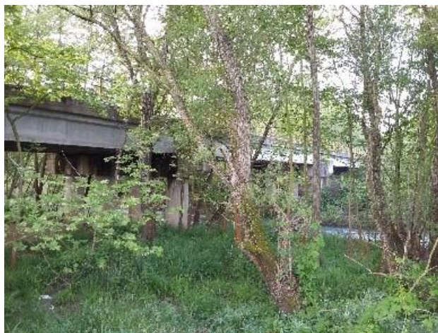
Εικόνα 3: Γέφυρα Καστριού – Μεσοποταμίας.
