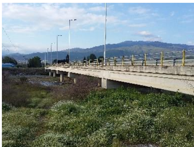
Εικόνα 1: Γέφυρα Μακρακώμης – Σπερχειάδας.
