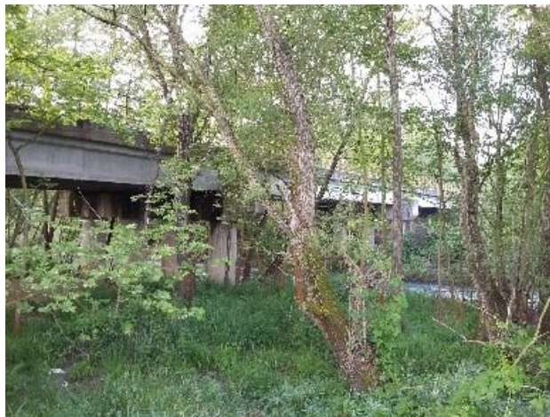
Εικόνα 3: Γέφυρα Καστριού – Μεσοποταμίας.
