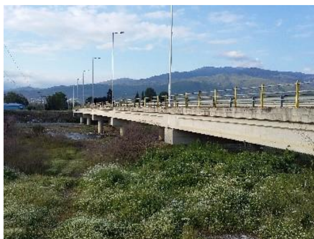
Εικόνα 1: Γέφυρα Μακρακώμης – Σπερχειάδας.
