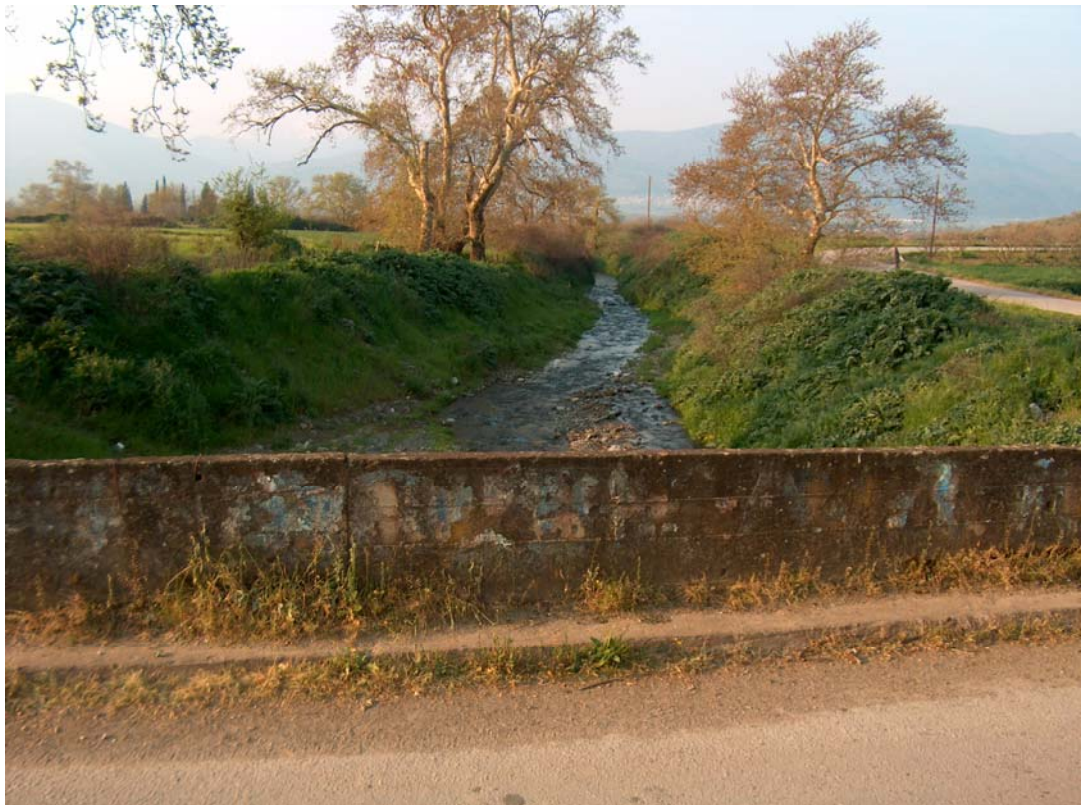
Αρχανιόρεμμα, από την υφιστάμενη γέφυρα προς κατάνη.
