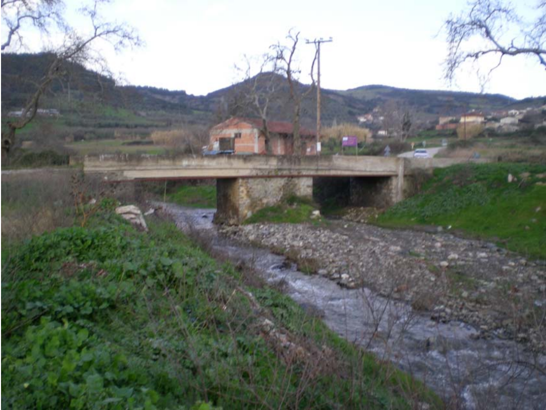
Υφιστάμενη γέφυρα από κατάνη.
