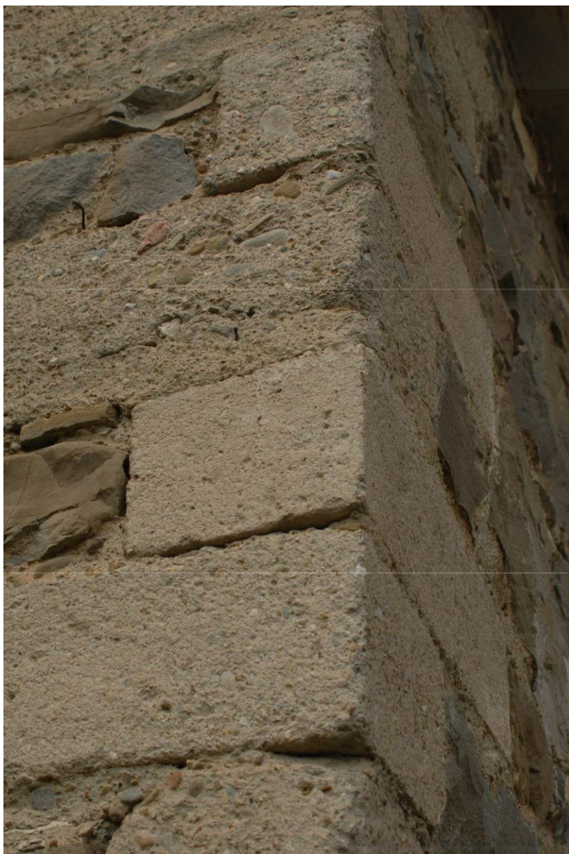
Φ6. ΓΩΝΙΟΛΙΘΟΙ ΧΥΤΟΙ ΑΠΟ ΣΚΥΡΟΔΕΜΑ
