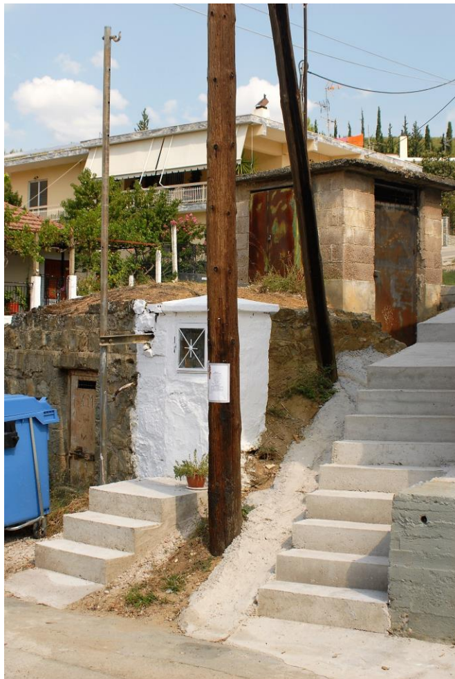
Φ10. Βόρειο τμήμα του οικισμού - Λίθινη κατασκευή.
